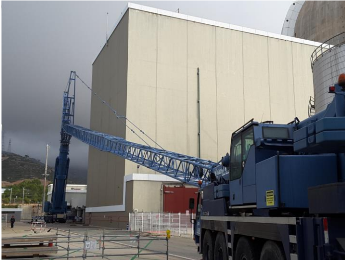
Trabajos de montaje de la grúa auxiliar para la instalación del sistema de venteo filtrado del edificio de la contención.
