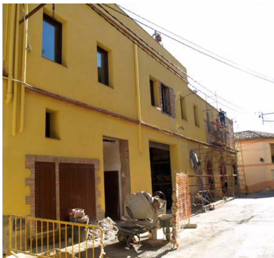
Façana de l'antiga cooperativa, actualment en obres.
