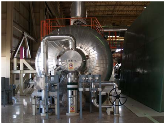
Uno de los cuatro MSR's que se cambiará en esta recarga.
